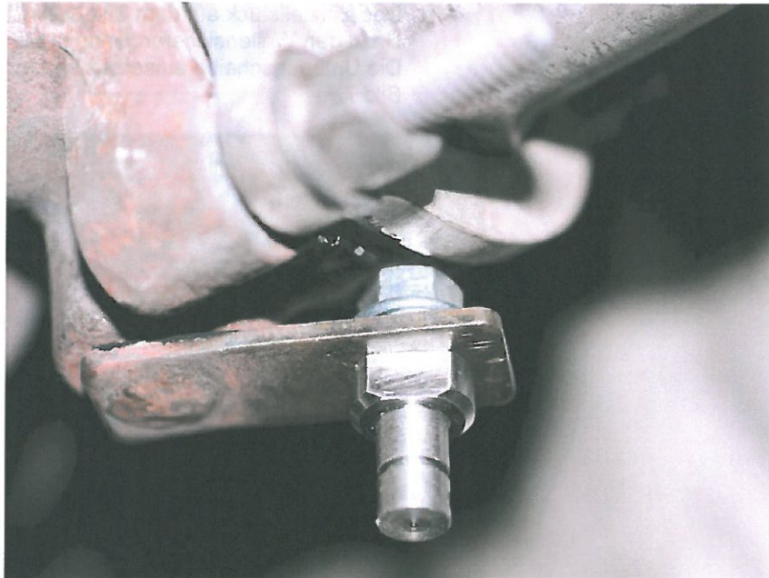
Bild 6 Befestigung des neuen Stiftes
