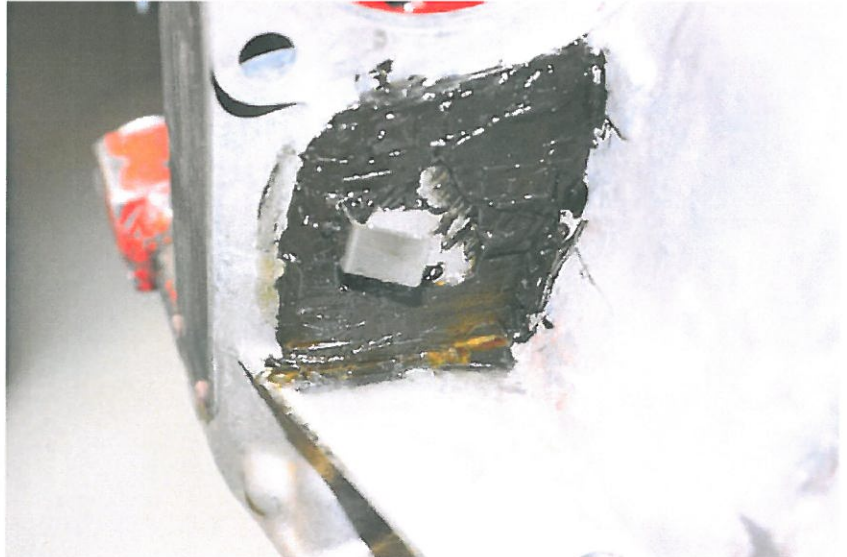
Bild 2 – Abgedichtete Montageöffnung Fig. 2 – Sealed assembly opening
